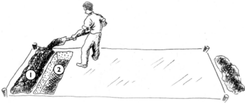
1- Primera zanja cama alta / 2- Segunda zanja
