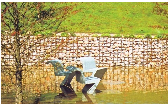
En el parque Diagonal Mar en la ciudad de Barcelona, un parque sustentable realizado sobre una zona industrial desmantelada, los gaviones se confeccionaron con mallas de alambres de construcción y cascotes de la demolición.
