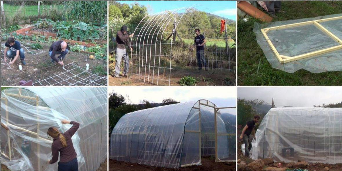
Estructura de malla electro soldada con madera y nylon
